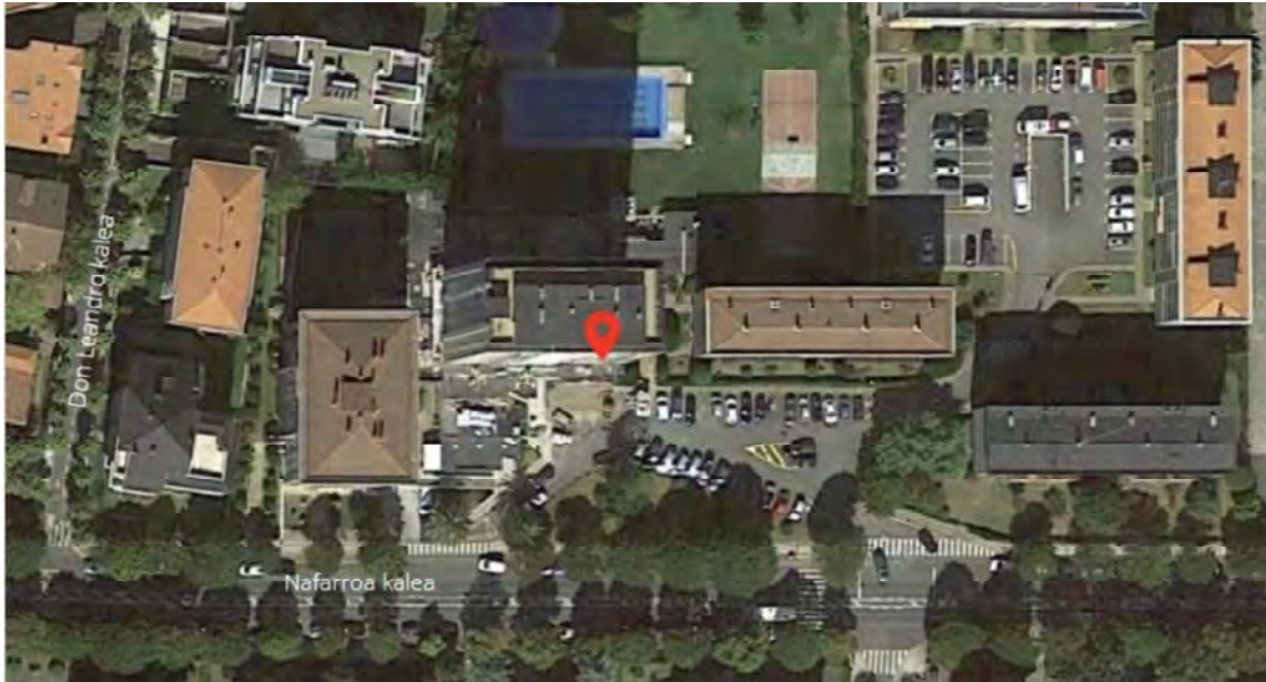
ARAZIren instalazioak, aireko argazkia
